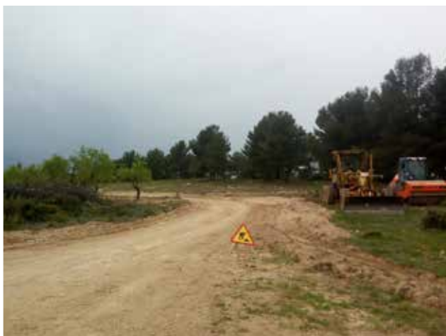
Reparación de los accesos / EPDA
