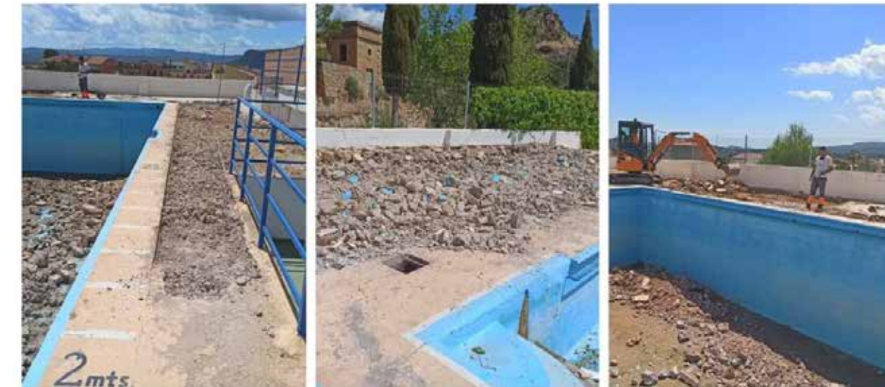
Las labores de reforma de la piscina municipal / AYTO. DE LOSA DEL OBISPO
