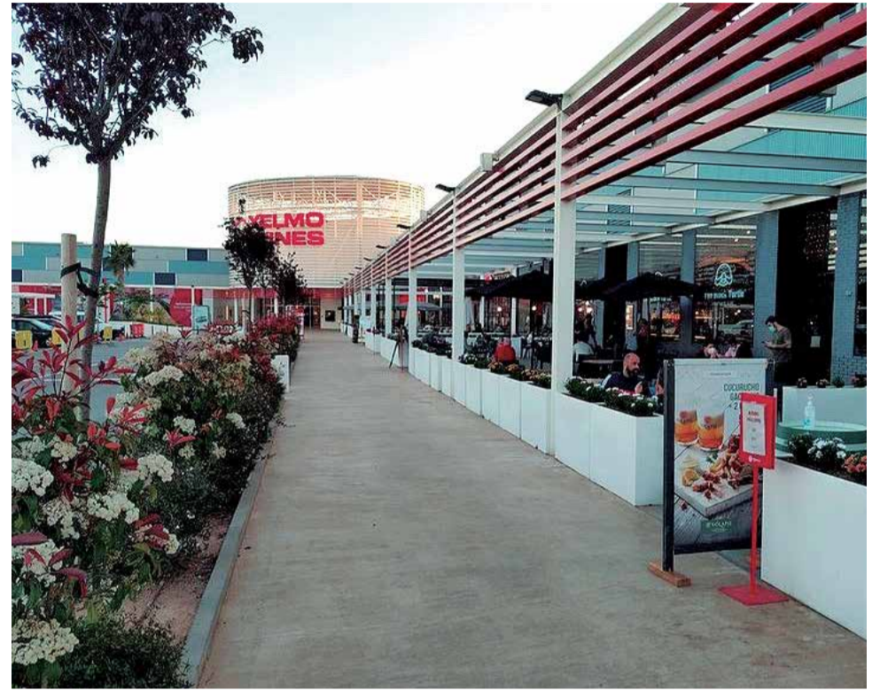
Parque comercial Vidanova Parc. / EPDA
