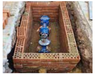
Una de las obras. / EPDA
