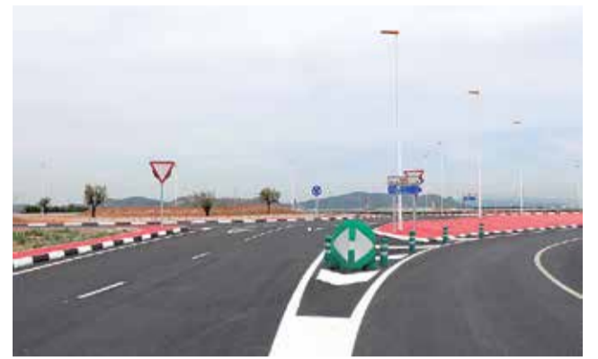
La nueva rotonda. / EPDA
