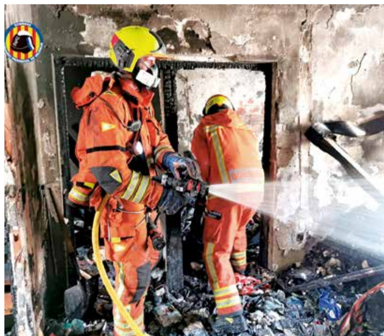
Vivienda afectada por el incendio. / CONSORCI DE BOMBERS DE VALÈNCIA
