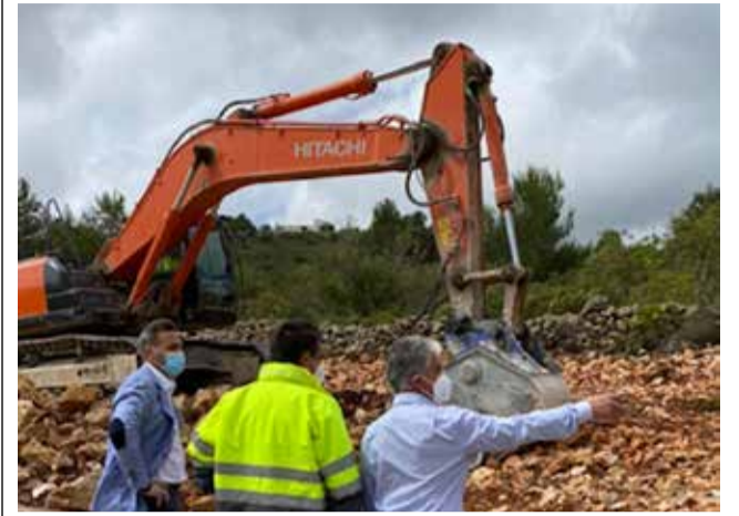
Visita a las obras. / EPDA
