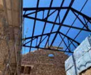
Obras de la bodega. / EPDA
