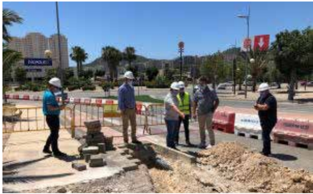
Obras de mejora. / EPDA
