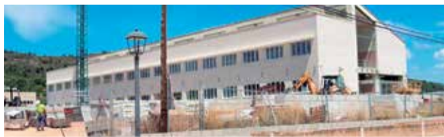
Obras en el instituto de Algímia. / EPDA
