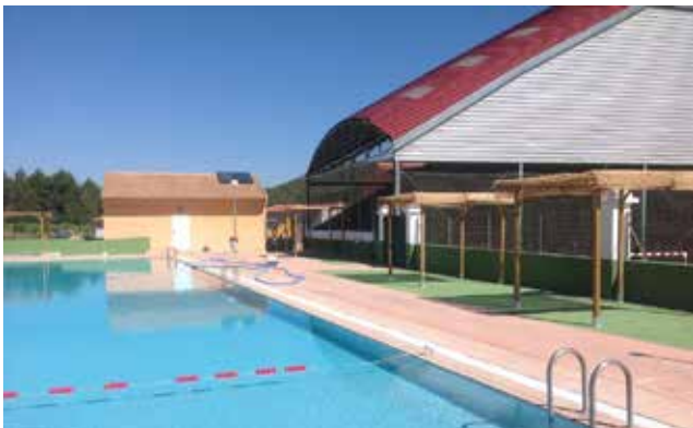
Piscina municipal de Benagéber. / EPDA
