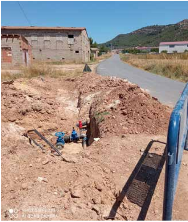
Las obras de mejora / EPDA
