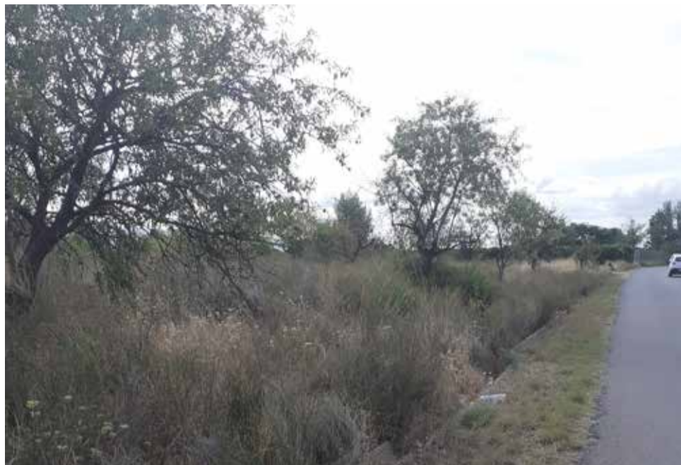
Una de las cunetas tras las labores de mejora en Casinos / EPDA
