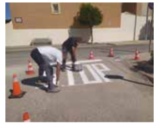
Las obras / EPDA
