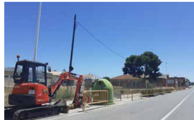
Tareas de reparación en Casinos. / EPDA
