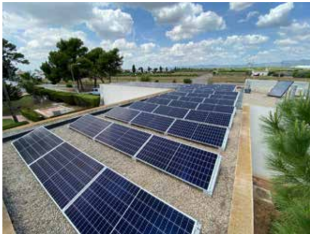
Placas solares colocadas. / EPDA
