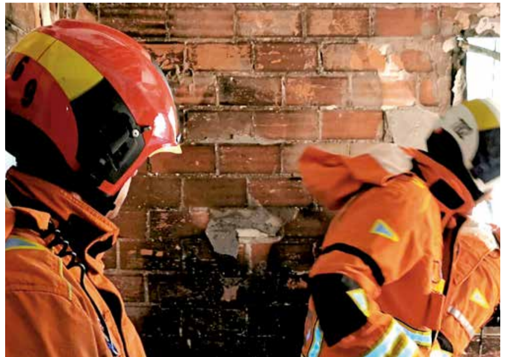
Interior de la vivienda del incendio de Alberic. / EPDA
