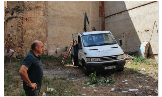
Començant l'adequació de la parcel·la. / EPDA
