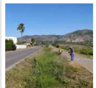
Tareas de desbroce. / EPDA
