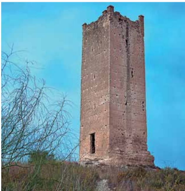
La Torre Espioca está ubicada en Picassent. / EPDA
