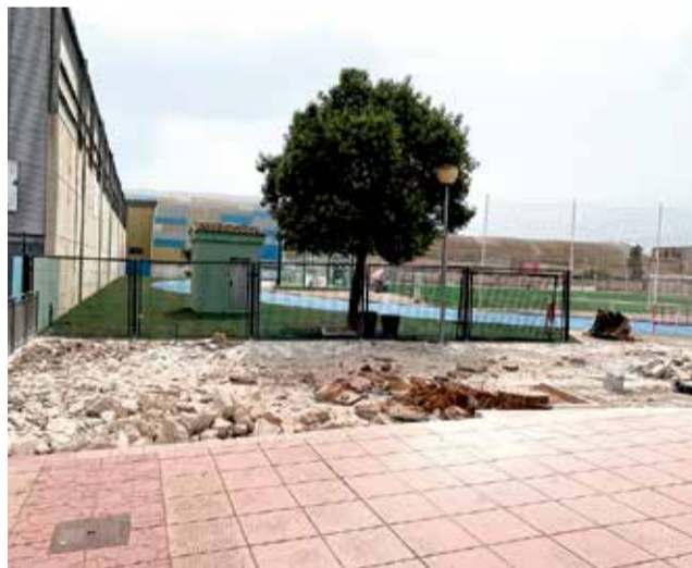
Pabellón municipal de Benifaió. / EPDA
