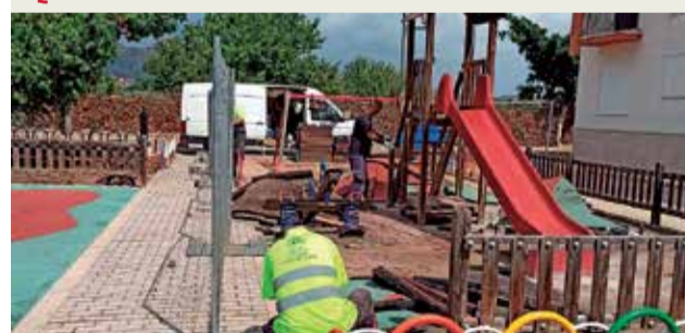
► En proceso la renovación del patio de recreo 'El Lla-vaner' de Quart Las obras finalizarán en septiembre.
