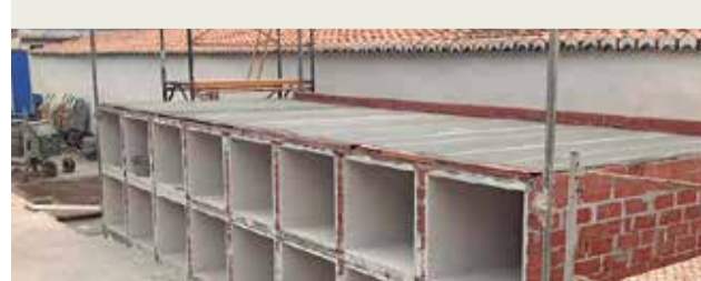
► Ampliación del cementerio de Faura: se construyen 32 nichos en cuatro alturas.
