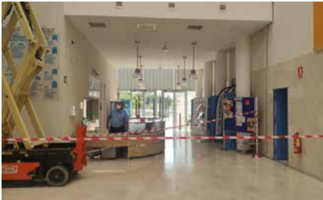
Obras de renovación. / EPDA
