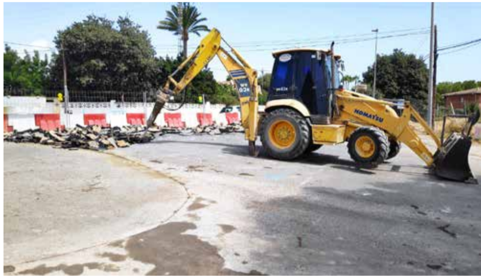
Obras de acceso. / EPDA
