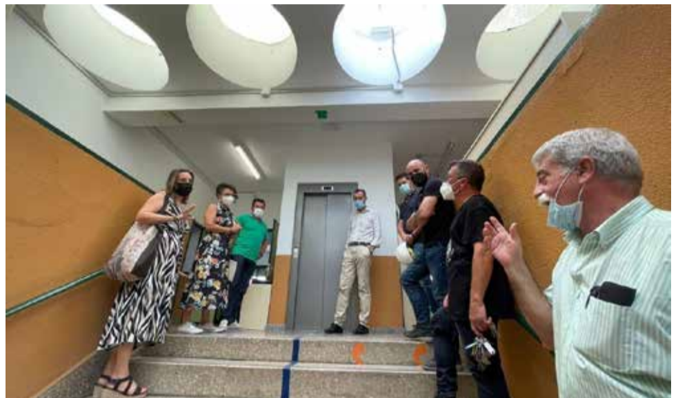
Ascensor instalado. / EPDA
