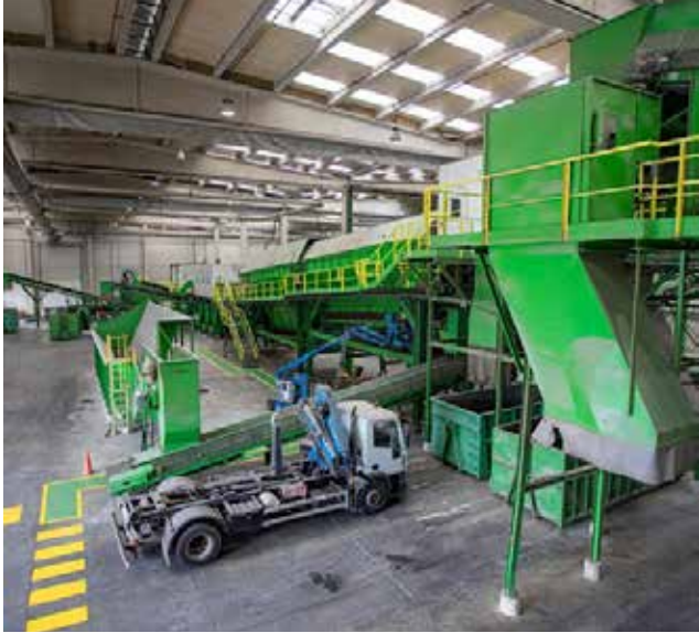
Camión del Consorcio Valencia Interior / EPDA
