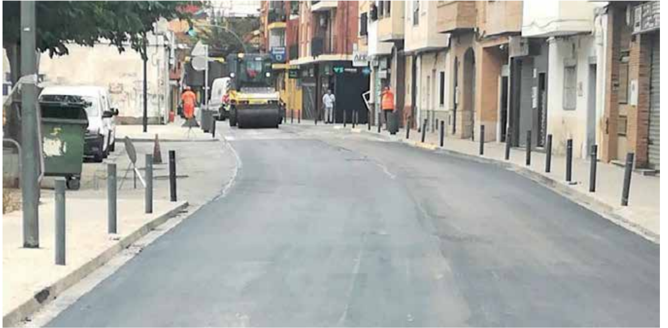
Treballs de millora als carrers d'Aldaia. / EPDA
