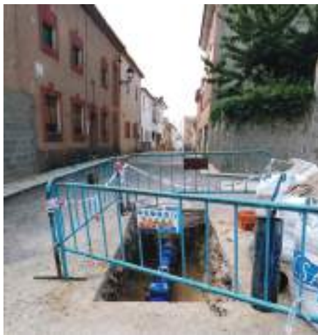
Realización de las obras / EPDA
