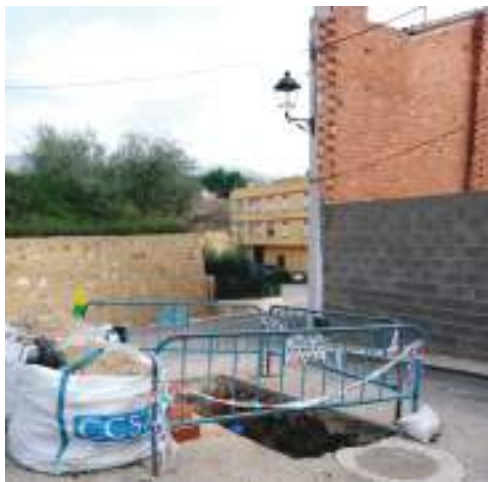
Obras en Higueruelas / EPDA
