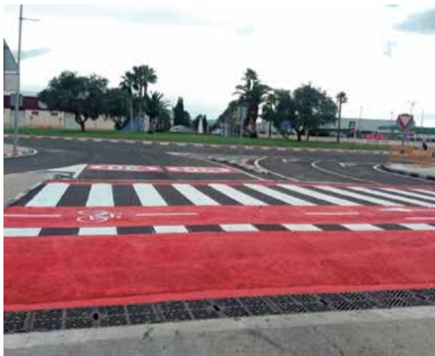
Carril bici de Algemesí. / EPDA
