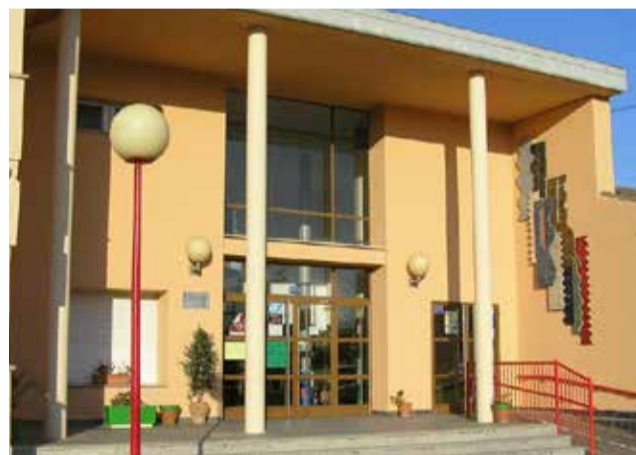
Entrada de CEIP El Garbí, en L'Eliaana / EPDA
