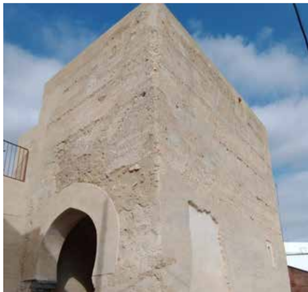
Se ha rehabilitado el Pont del Vidre iniciadas / EPDA
