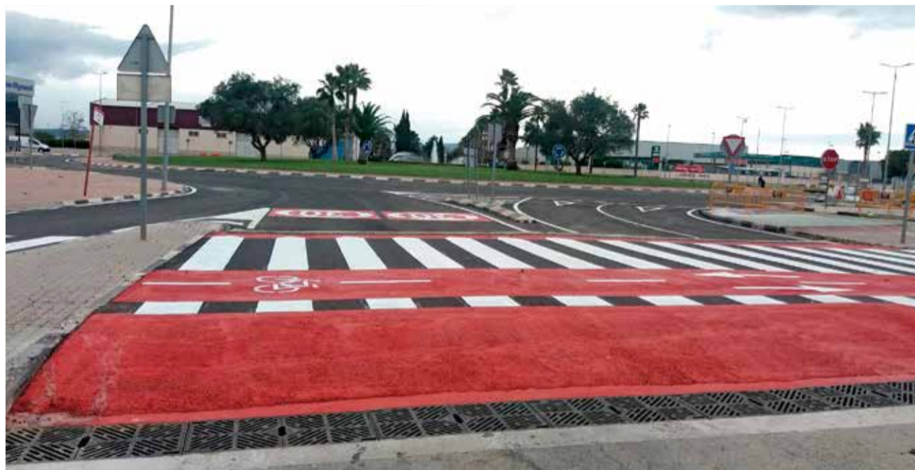
Carril bici al paso de la localidad de la Ribera Alta, Algemesí. / EPDA
