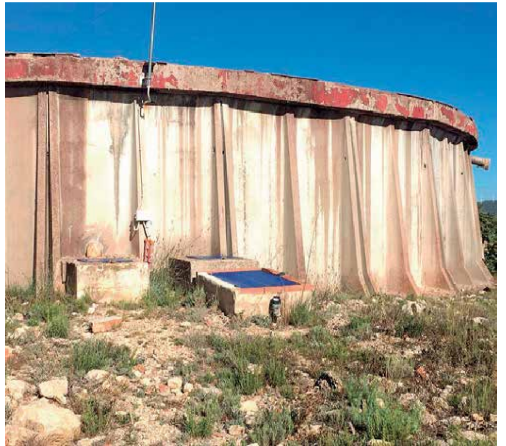
Depósito de Bicuerca de Camporrobles. / EPDA
