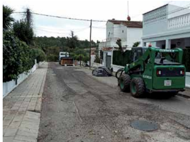
Acondicionamiento calle Macastre. / EPDA
