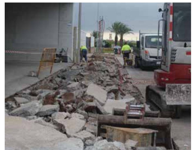
Obres de millora. / EPDA
