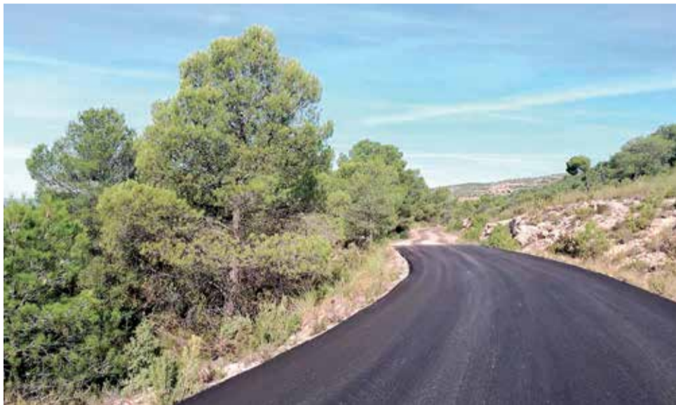
Acondicionamiento del camino Casa de Moya a Los Cárceles./ EPDA
