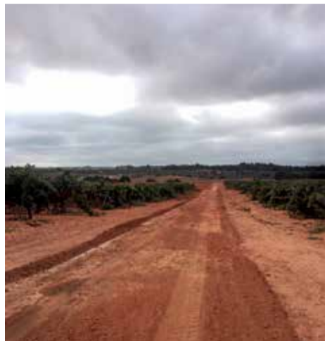
Obras del Río Madre. / EPDA
