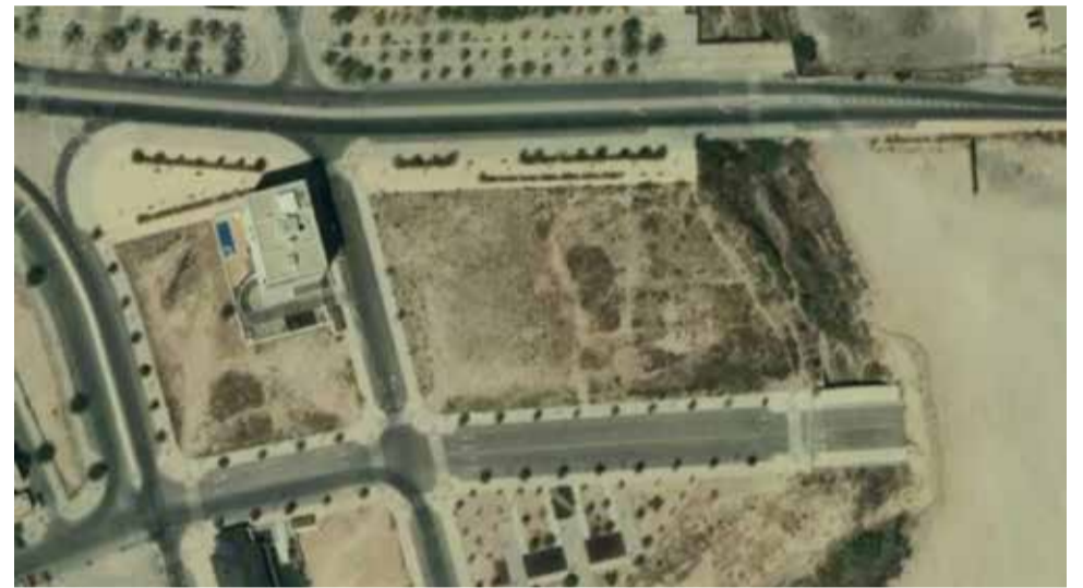
Ubicación del centro Elx-Travalón. / EPDA
