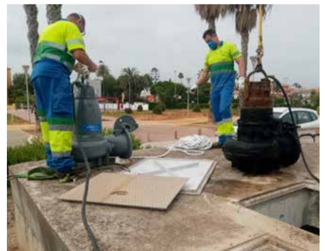
Mejora de la red de pluviales. / EPDA
