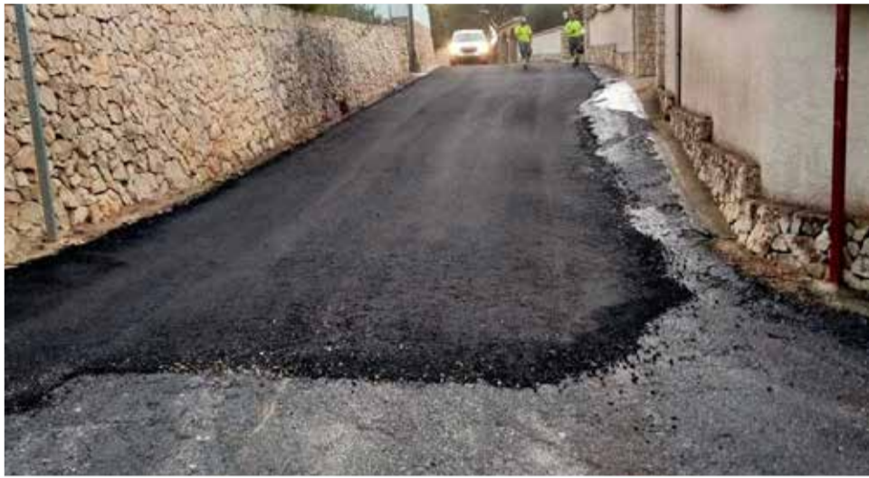
Asfaltado en Cap de la Nau. / EPDA
