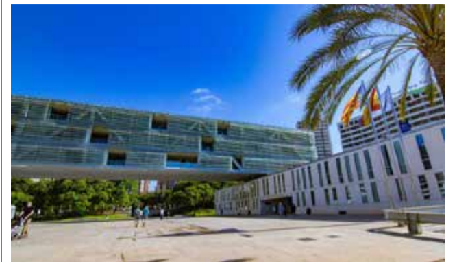
Edificio de Hacienda. / EPDA
