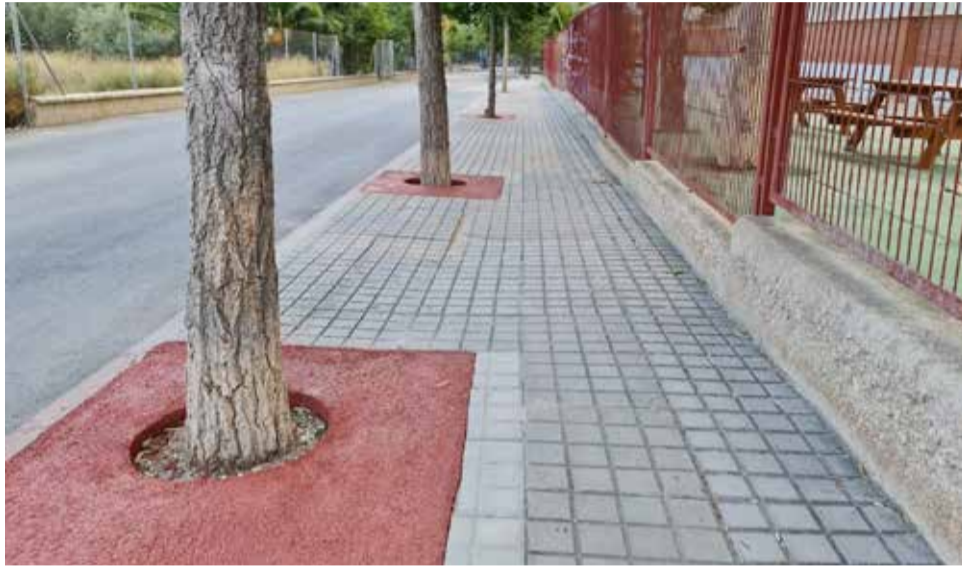
Reparación de las aceras. / EPDA
