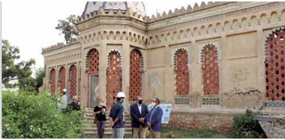
Visita a los trabajos en Torrent. / EPDA
