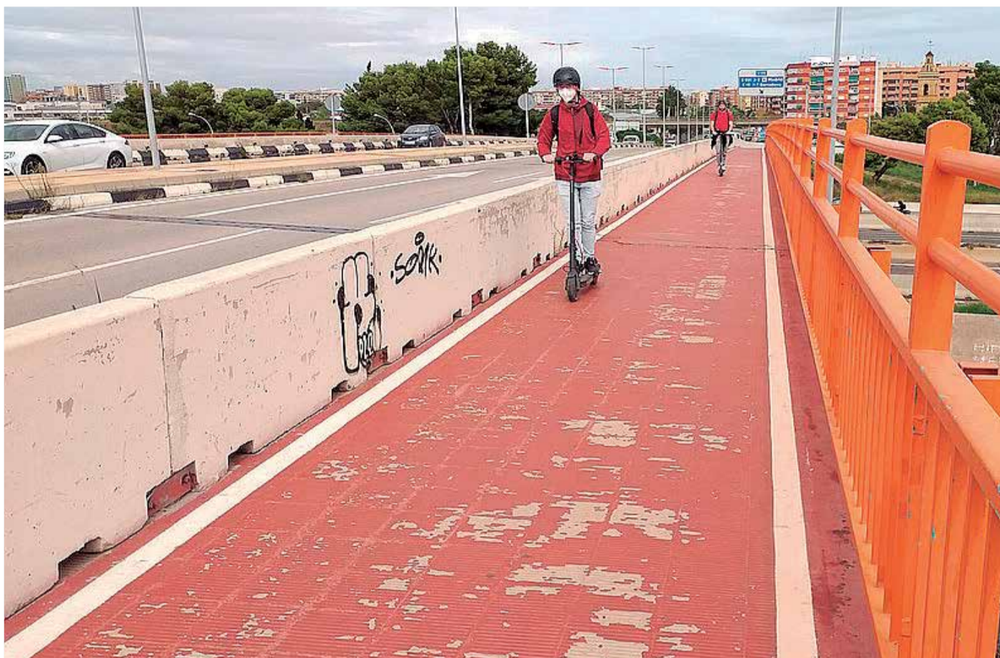
Paso ciclopeatonal en la CV-36. / EPDA
