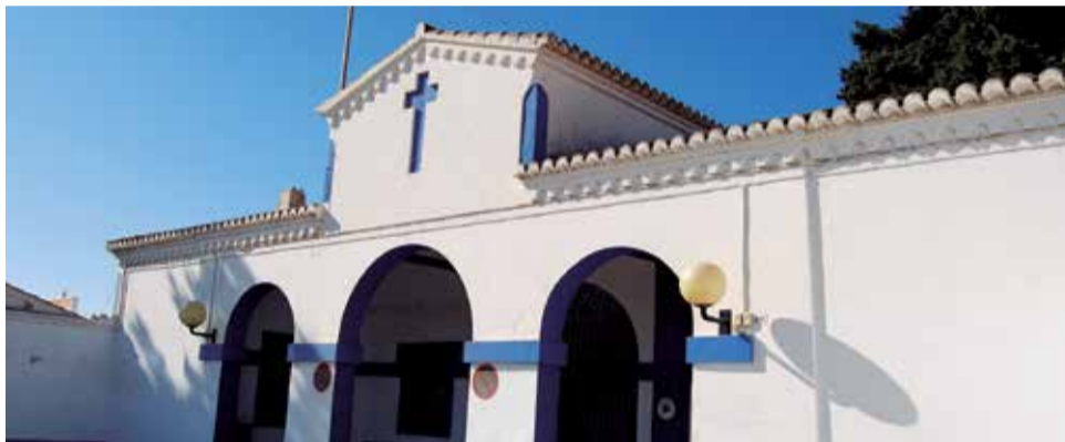
Fachada del cementerio municipal de Sagunt. / EPDA
