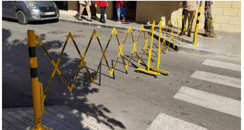
Vallado perimetral. / EPDA
