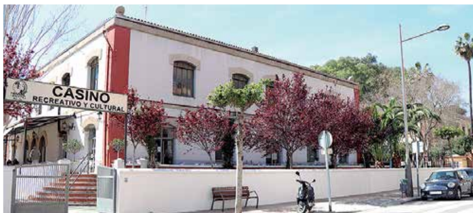
Antiguo Casino Gerencia de Altos Hornos del Mediterráneo en Port de Sagunt. / EPDA
