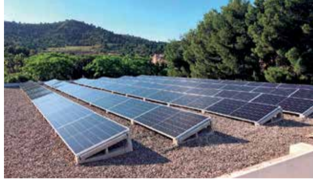
Instal·lació de plaques solars a l'Auditori. / EPDA
