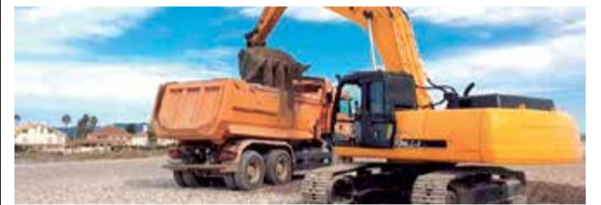
Operarios retiraban grava en octubre. / EPDA
