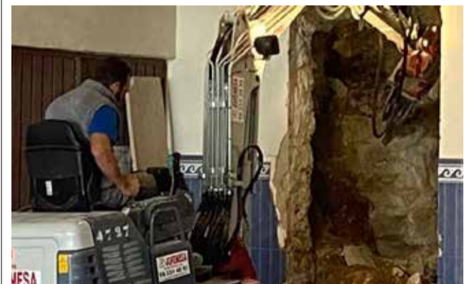
Obras en el Centro Cultural de Càlig. / EPDA
