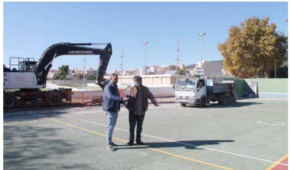
Obras en el polideportivo municipal. / EPDA
