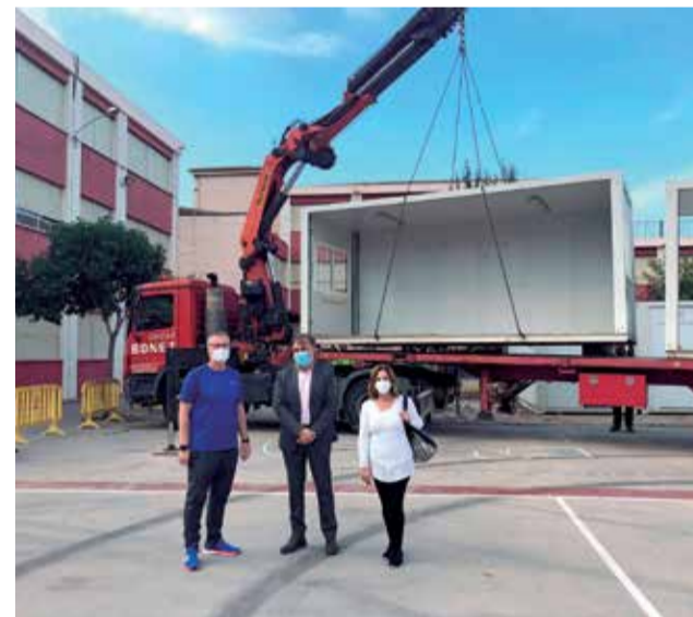
Retirada barracons./ EPDA
