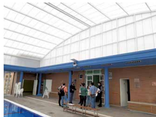
Visita a les Piscines Municipals. / EPDA
