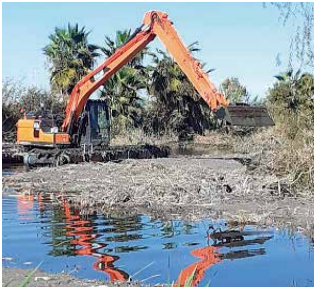
Obras del Carreró de Sueca. / EPDA
