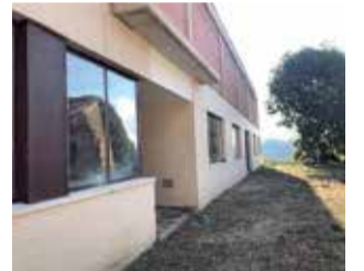
Edificio polivalente. / EPDA
