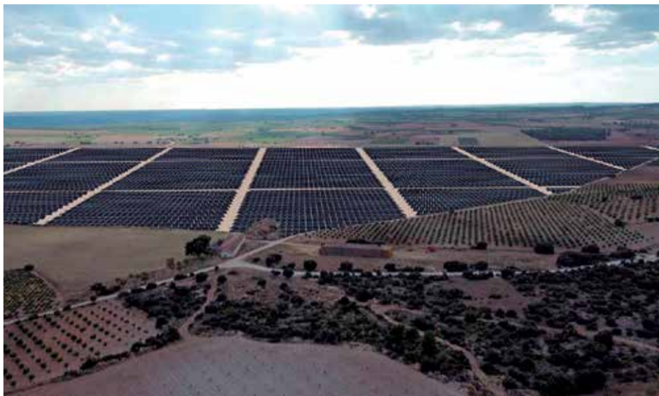
Placas fotovoltaicas. / EPDA
