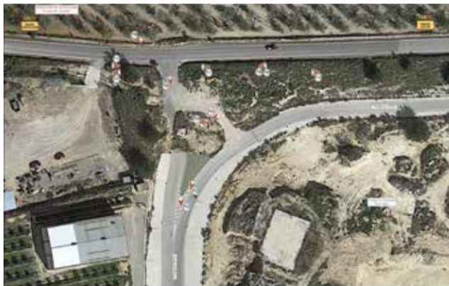
Obras polígono de Ceste. / EPDA
