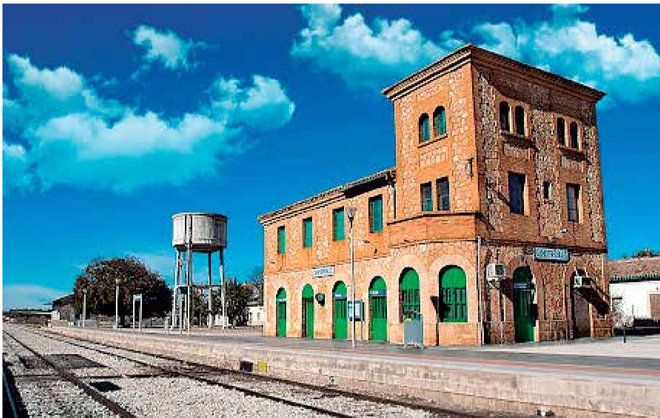
Estación de tren de Camporrobles. / EPDA
