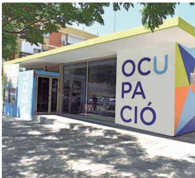
Instalaciones de empleo en Alfatar. / EPDA
