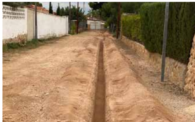
Una de les obres durant l'execució. / EPDA
