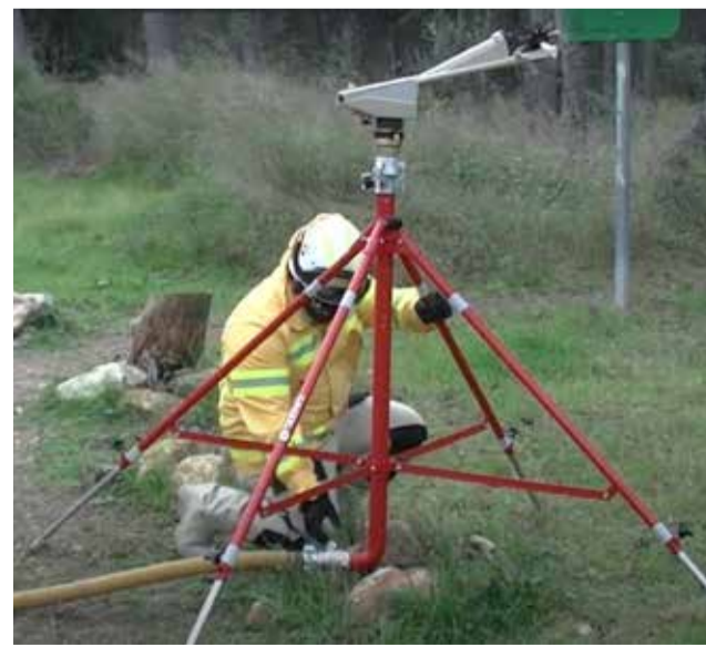
Instal·lació d'un dels canons / EPDA
