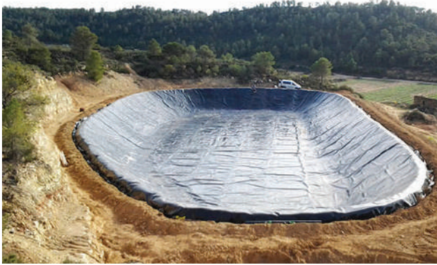
Un ejemplo de una balsa de almacenamiento. / EPDA
