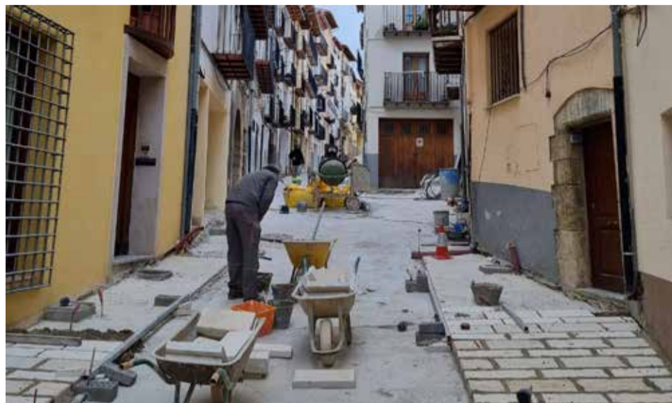
Obres de millora. / EPDA
