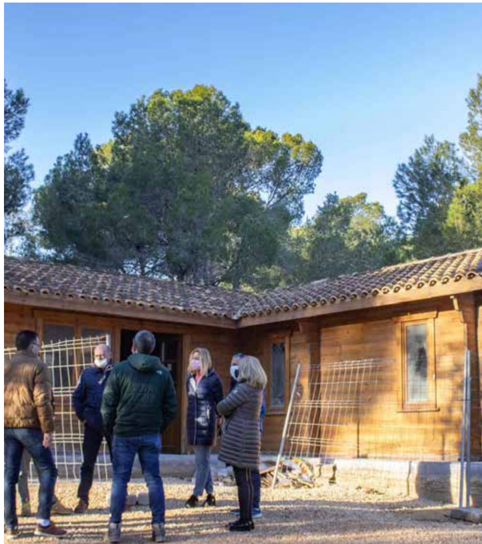
Inicio de las obras del Moralet. / EPDA
