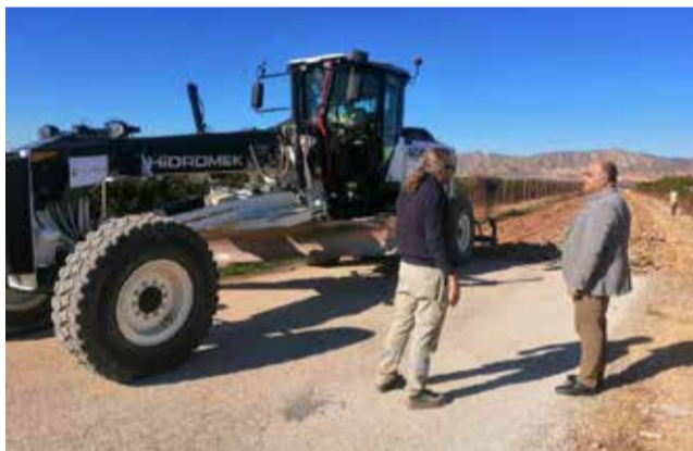
Camino agrícola en reparación. / EPDA
