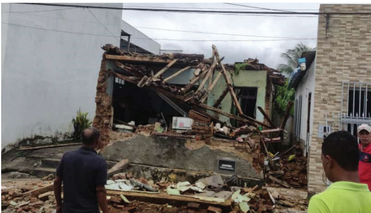
Casa derrumbada en Bahía tras las inundaciones de diciembre. / EPDA
