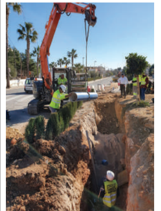
Las obras. / EPDA
