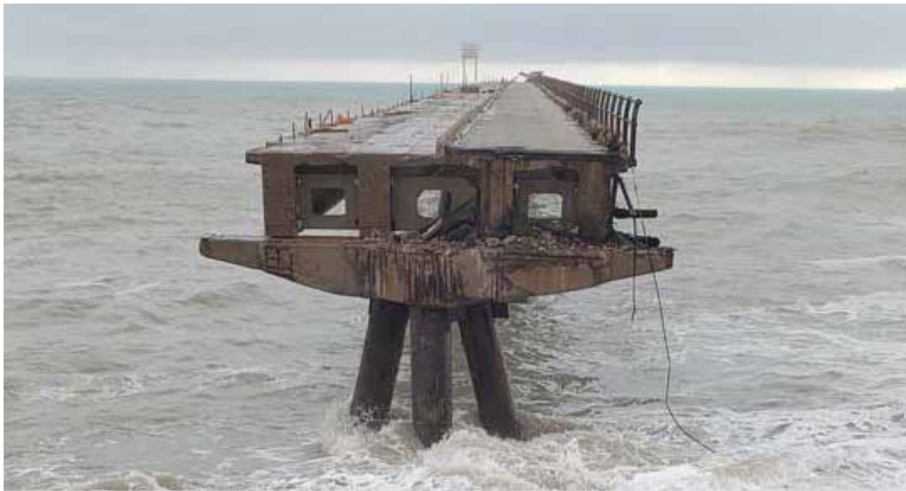
Estat actual del Pantalà de Port de Sagunt. / EPDA
