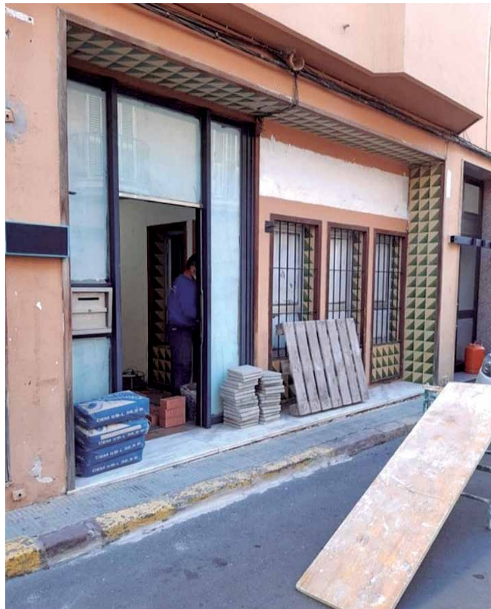
Obras del cajero en Quart de les Valls. / EPDA
