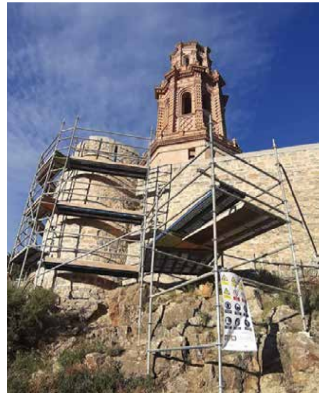
Obras en una de las torres de Jérica. / EPDA
