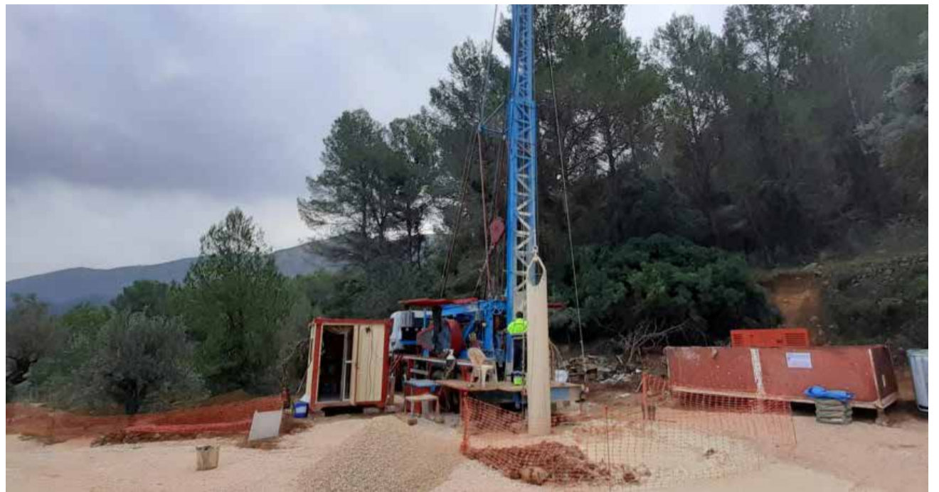
Sondeo del nuevo pozo. / EPDA
