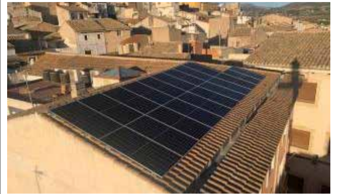
Placas instaladas. / EPDA
