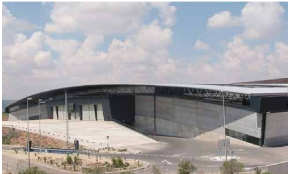
Planta de Tratamiento de Residuos de Villena. / EPDA
