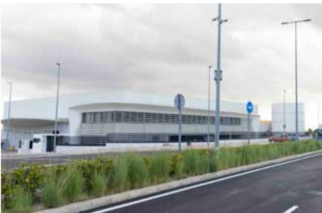
Un dels polígons on s'han portat les obres de millora. / EPDA
