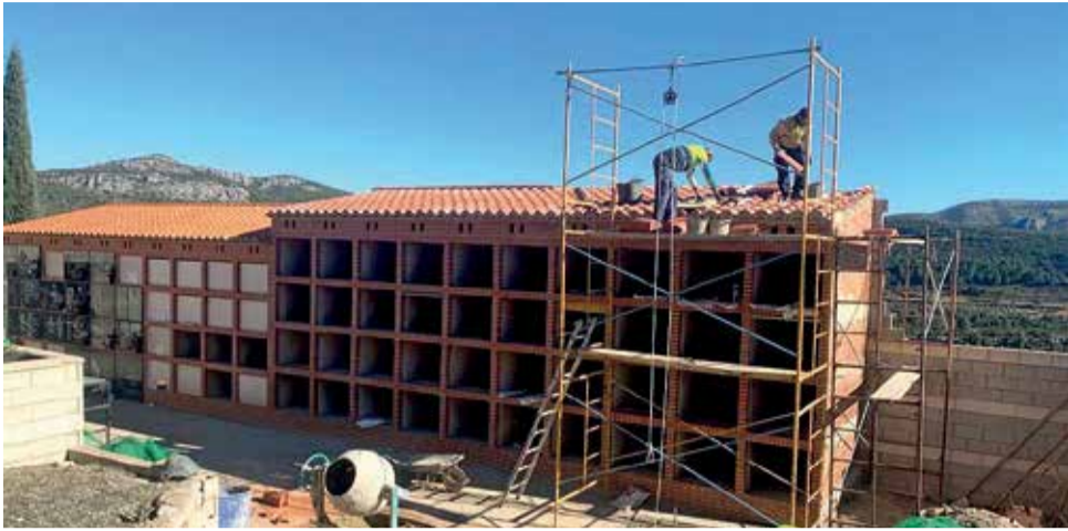
Construcción de los 40 nichos en el cementerio de Chera. / EPDA
