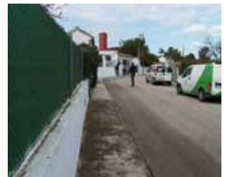
Nuevas iluminarias. / EPDA
