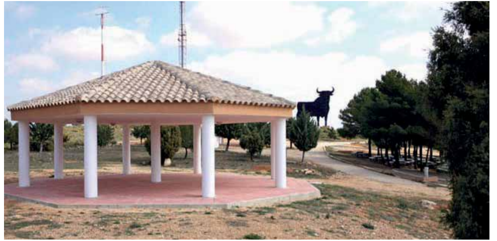
Depósito de agua potable de Villargordo del Cabriel. / EPDA
