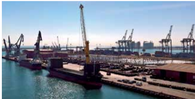
Panorámica del puerto de Sagunt. / EPDA
