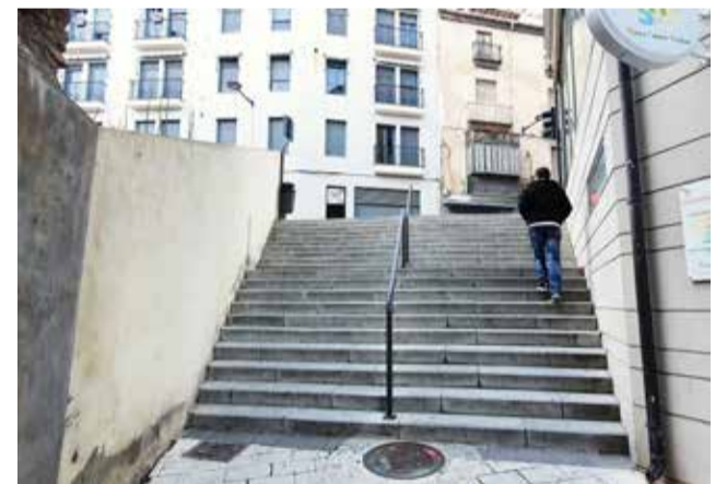
Escaleras en el municipio de Xixona. / EPDA
