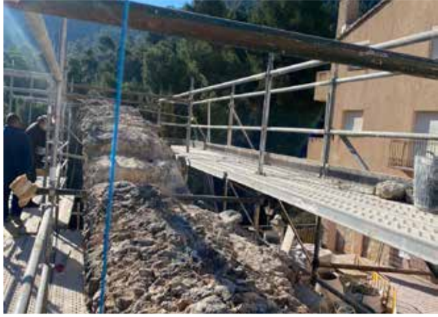
Trabajos de recuperación. / EPDA
