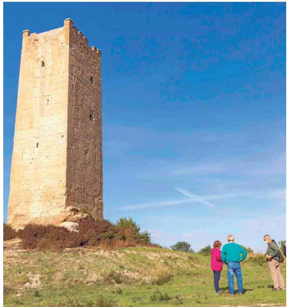
Trabajos en la Torre Espioca de Picassent. / EPDA
