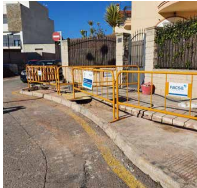
Obras de renovación de la red de agua. / EPDA
