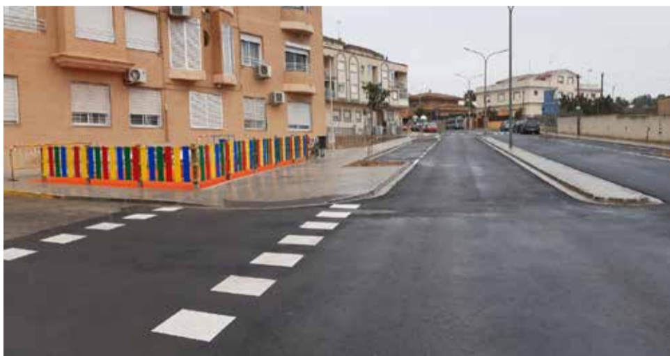
L'avinguda del Regne de València després de les obres / EPDA
