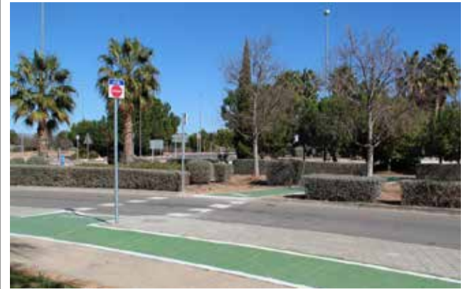
Carril ciclopeatonal en la zona. / EPDA
