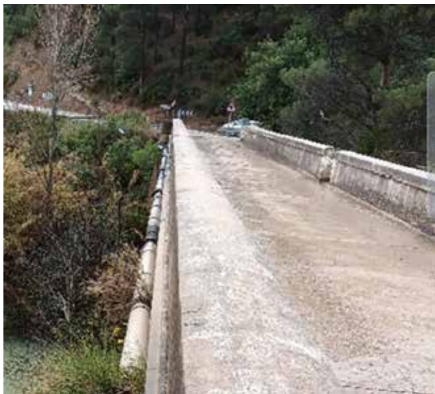
La zona de la tubería, al lado de la naturaleza / EPDA
